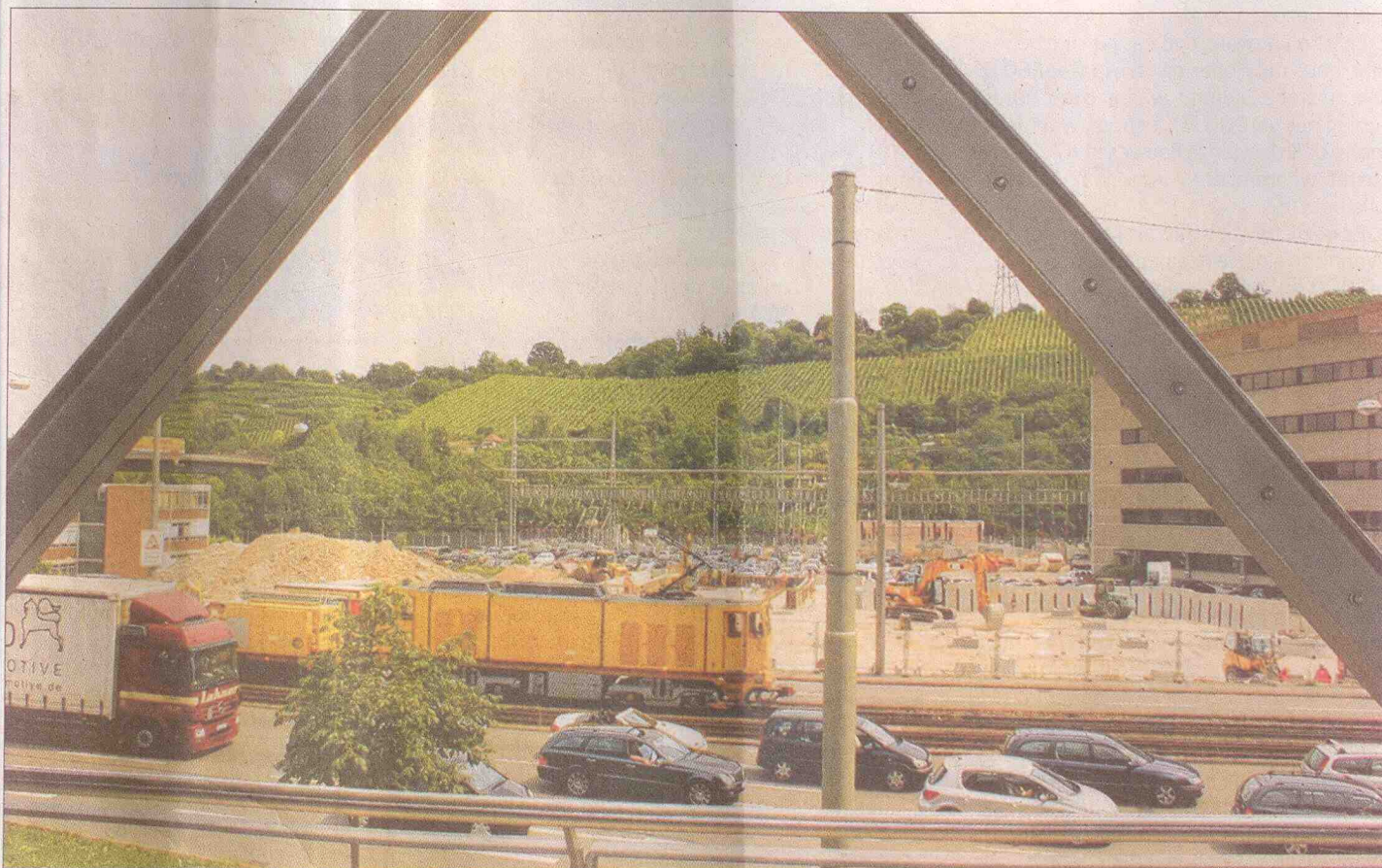
Das Grundstück der Firma Kiefer an der Heilbronner Straße soll teilweise neu genutzt werden. Dort wird ein Baumarkt verwirklicht.
