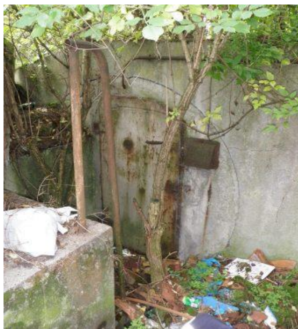
Zugang zum Bunker. Die Röhre ist gut an der Rissbildung zu erkennen. Rechts neben dem Eingang ist der Luftzugang, geschützt mit einem Auer Luftblech, zu erkennen.
