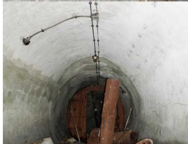
Zugang zum Bunker. Die Röhre ist gut an der Rissbildung zu erkennen. Rechts neben dem Eingang ist der Luftzugang, geschützt mit einem Auer Luftblech, zu erkennen.
